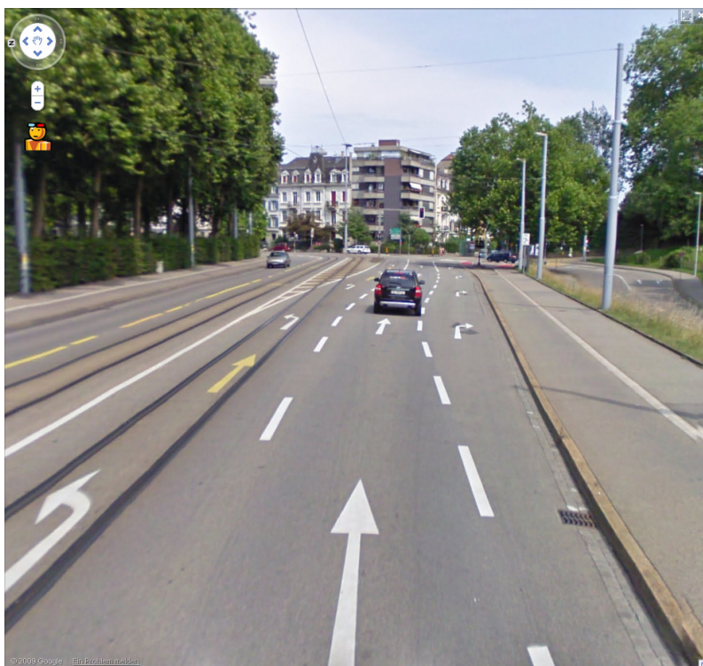
Abbildung 1: Zufahrt vom Dorenbachviadukt her mit aktueller Spuraufteilung (Quelle: Google Maps)
